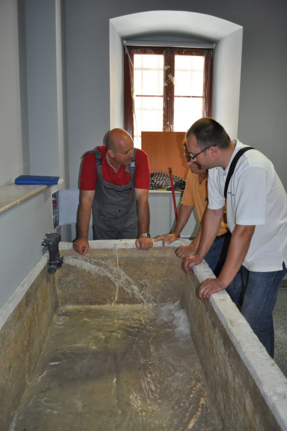
Prova di tenuta della vasca
