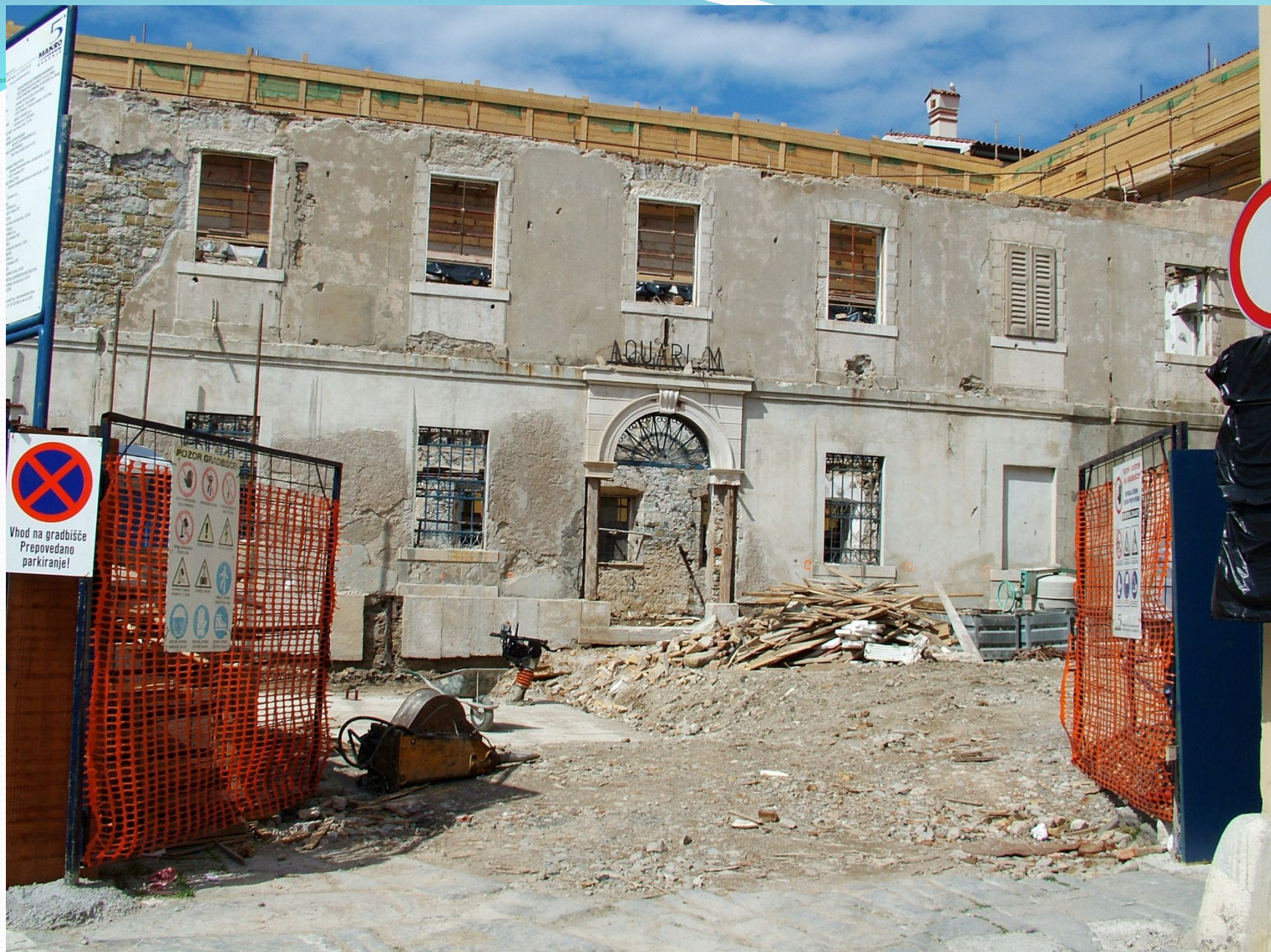
Cantiere: inizio dei lavori gennaio 2008
