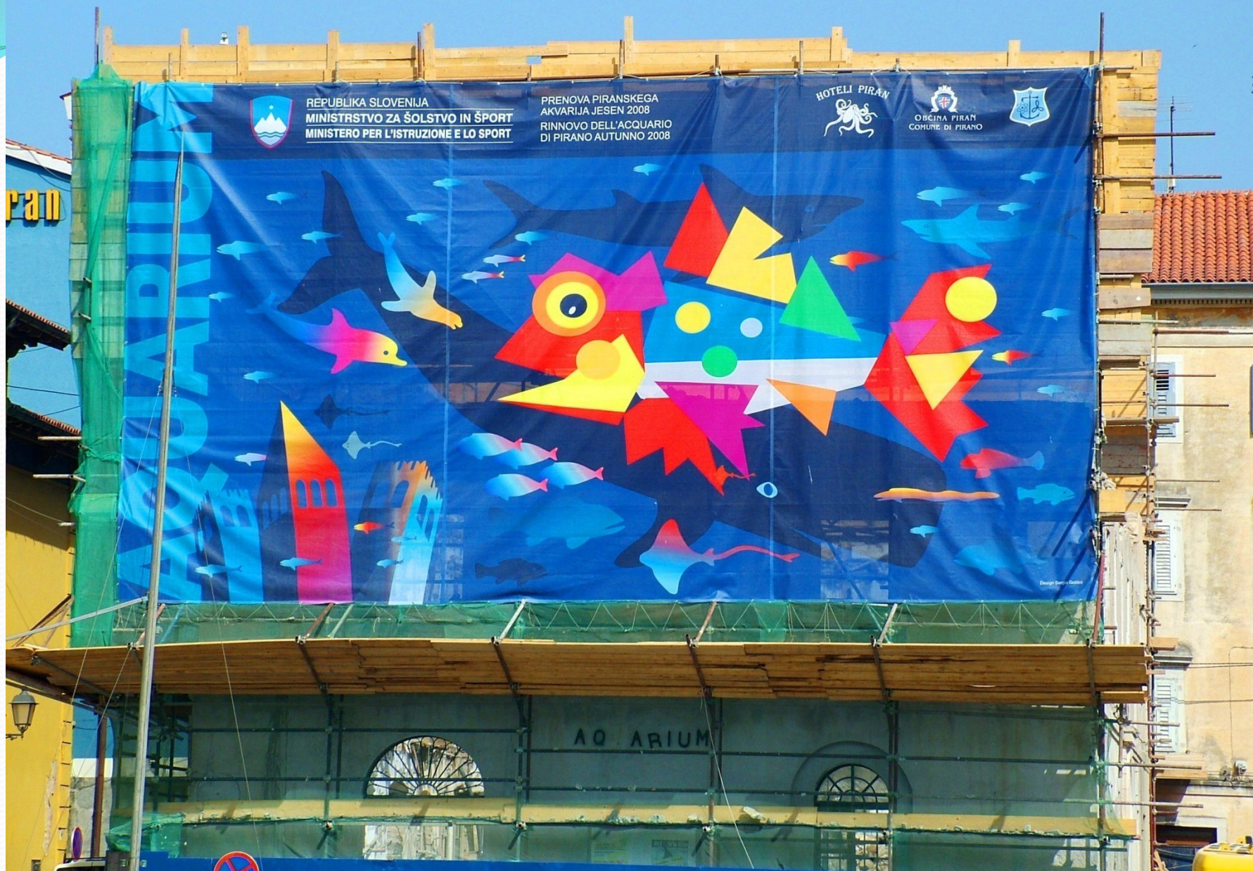
Innizio lavori per l' Acquario di Pirano
