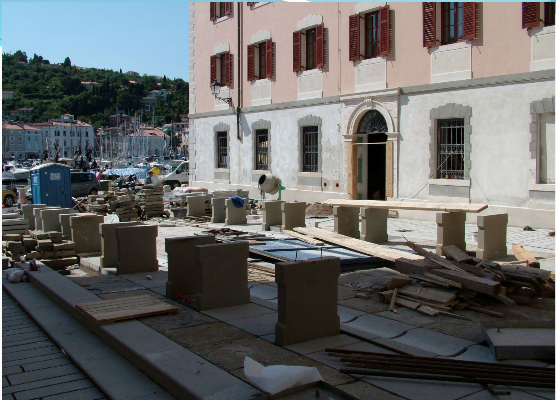
Lavori sul piazzale davanti L'Acquario
