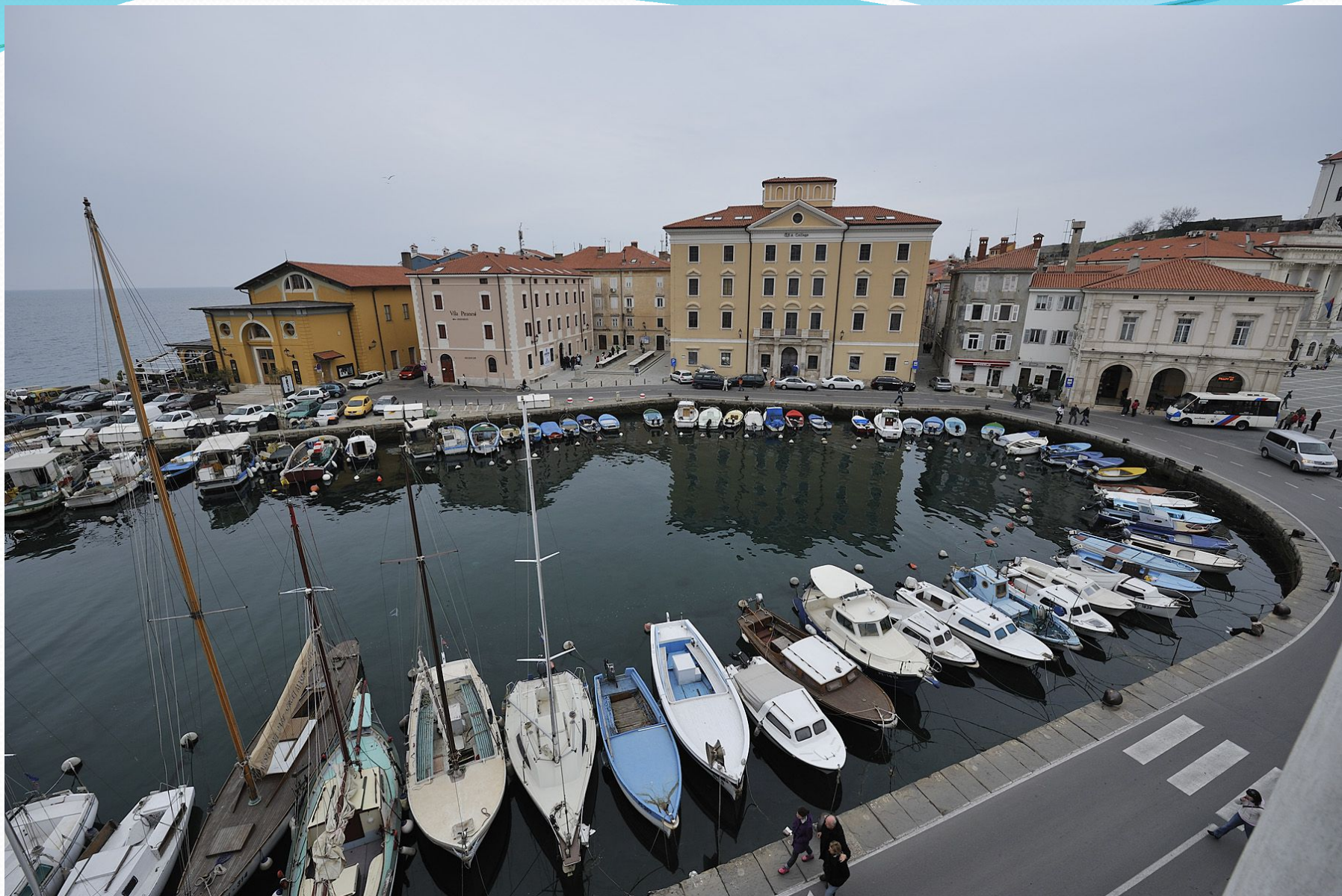
L' edificio nuovo con il mandracchio
